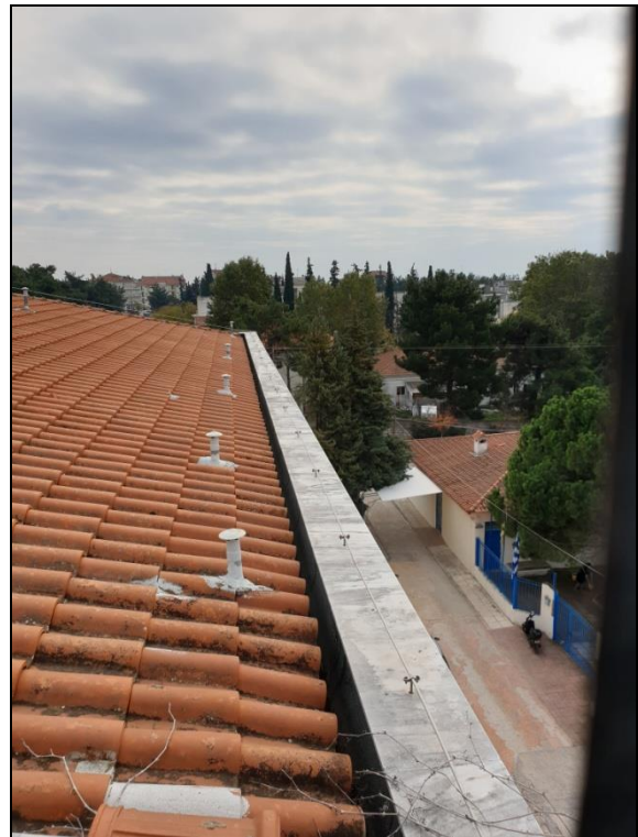
Εικόνα 3. Κέντρο Υγείας Κιλκίς
