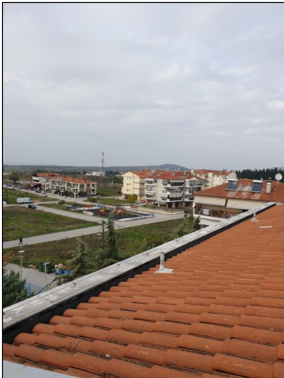
Εικόνα 2. Κέντρο Υγείας Κιλκίς
