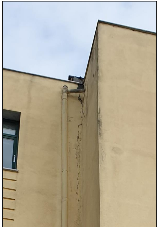
Εικόνα 11. Κέντρο Υγείας Κιλκίς
