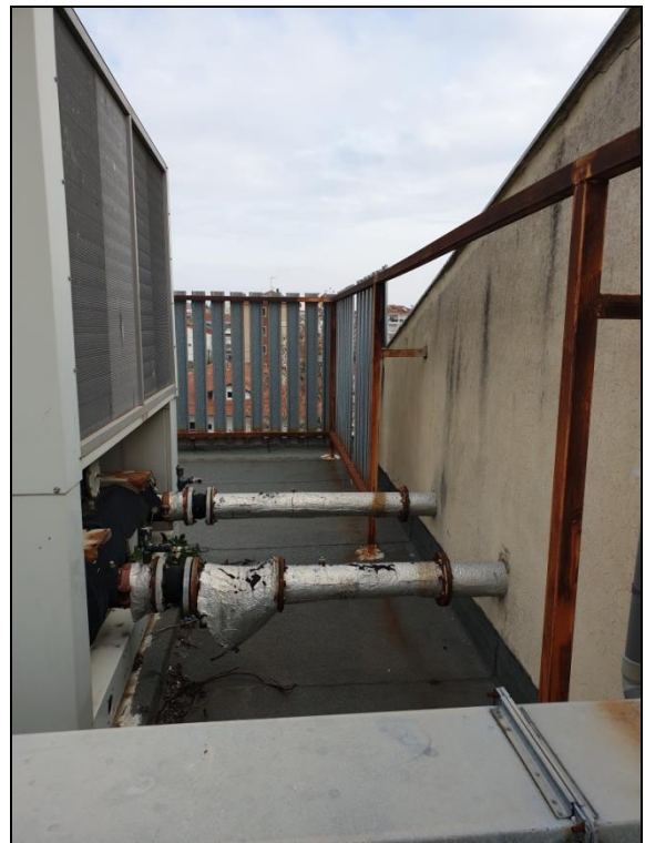
Εικόνα 7. Κέντρο Υγείας Κιλκίς
