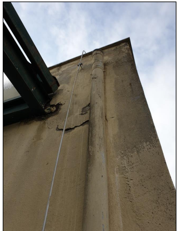
Εικόνα 12. Κέντρο Υγείας Κιλκίς
