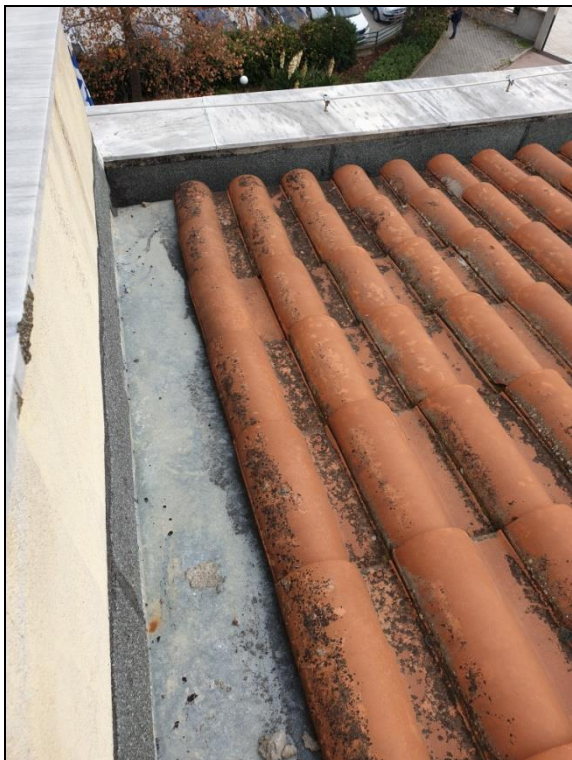
Εικόνα 5. Κέντρο Υγείας Κιλκίς
